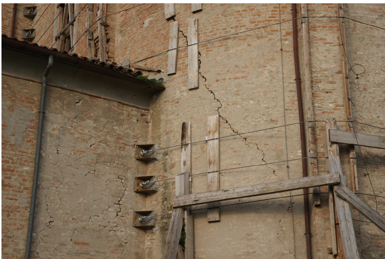
lato Ovest/Sud - Abside . Presenza consistente di stesure di intonaci antichi (vedi foto successiva)
